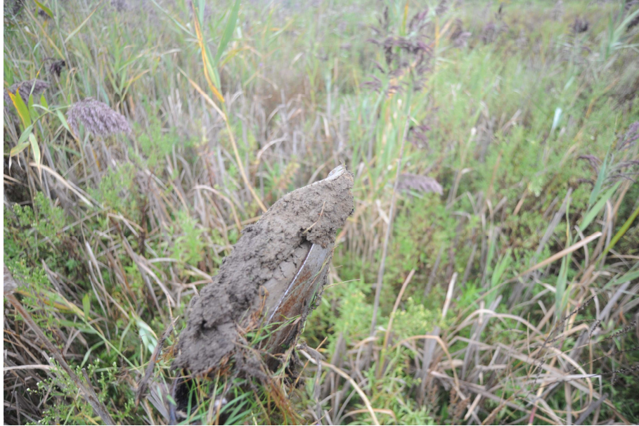
Photographie 11: Sol compacté du fossé (noue) sur le site.
