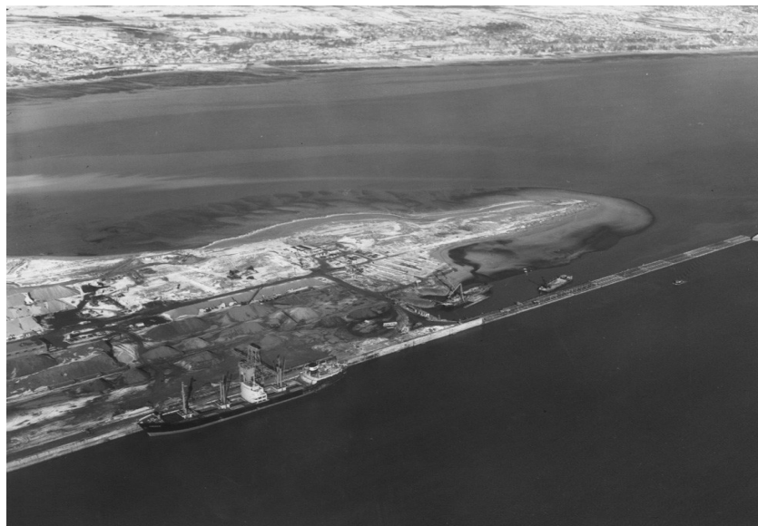
Photo 2 : Remblaiement de la péninsule portuaire de Beauport (années 1960)
